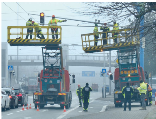
Práce na výstavbe novej trate sú v plnom prúde aj na Botanickej ulici. Foto: Marek Velček
