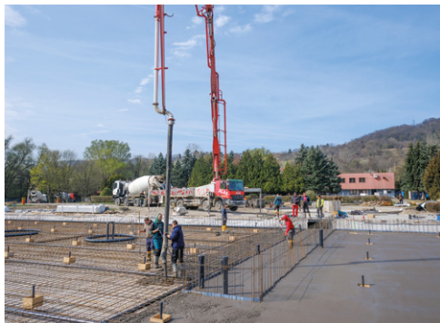
Na Rosničke betónujú bazénové telesá.
