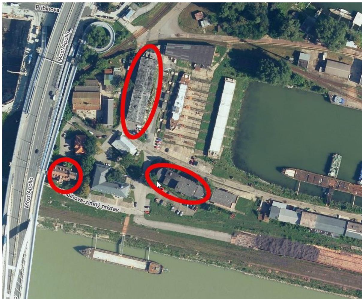
Obr. 2.1 – Objekty ktoré tvoria prekážku v prúdení vody pri povodni.
