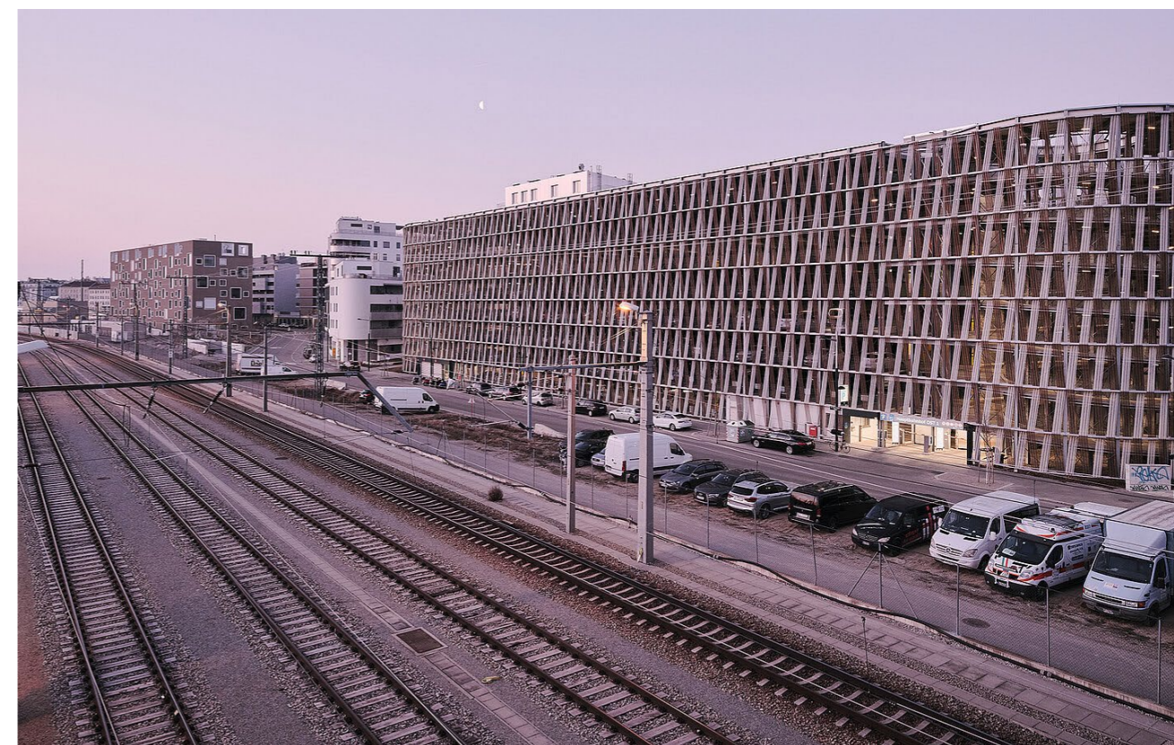
Obrázok 41: Parkovací dom Hochgarage Hauptbahnhof, Viedeň
