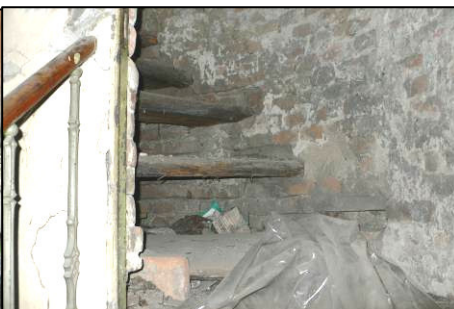
schodisko na povalu
