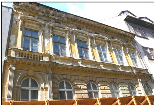
uličná strana domu
